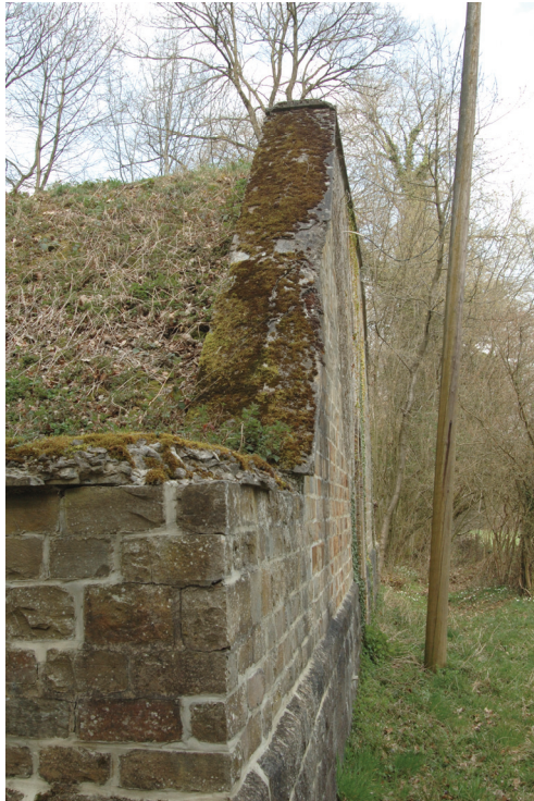
Station de captage d'eau au Bois de la Coumagne à Villers-Deux-Eglises
